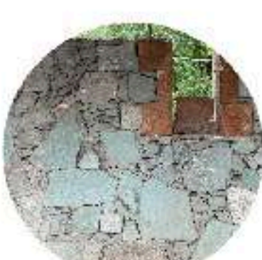
Для Дилижана характерно использование природного камня. Речной камень сложно обработать, поэтому кладка хаотичная, из камней неправильной формы. Цвета натуральные, серый, песочный, с включением камней голубых оттенков.
